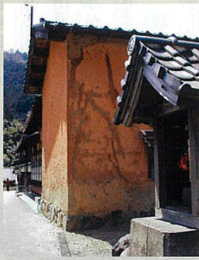
土蔵の赤土色が町並みの基調色となっている
