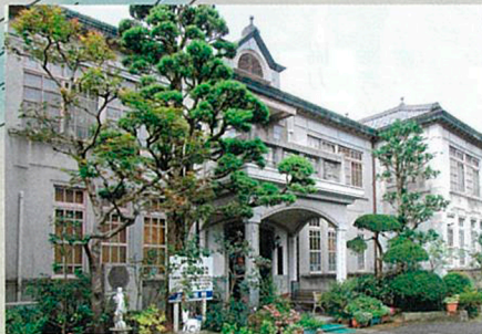
古い町並みの中で、ひと際目立つ洋館建ちのモダンな医院。玄関を中心として、左右対称にデザインされている。昭和5年の建設で、一度も改築されていないという。屋根中央には、換気窓が設置されている。
