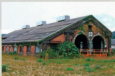
和田山駅のホームから見えるかつての機関庫。明治44年、播但線と山陰線の接続駅となったことにより、翌45年、機関庫と給水塔・転車台、引き込み線などが建設された。平成3年頃まで、現役として活躍したが、現在は老朽化のため、中は立入禁止となっている。全国的にも珍しいレンガ造りの機関庫で、半円型の入口部には、白御影石が用いられている。
