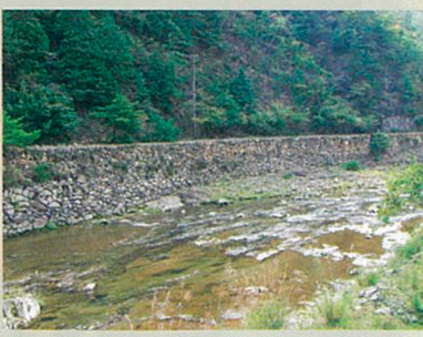
市川の対岸沿いには、鉱石を運んだトロッキの軌道跡が残る。山の斜面には坑口が点在している。
