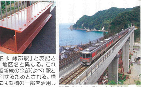
駅名は「餘部駅」と表記され、地区名と異なる。これは姫新線の余部(よへ)駅と区別するためとされる。構内には鉄橋の一部を活用したベンチが置かれている。
