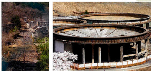
液体中に混じる固体粒子を分離する装置「シクナー(右)」は百尺(約30メートル)の他に、55尺(約16メートル)がある。選鉦場の昇り降りを行った「ケーブルカーの軌道跡(左)」。頂上の操作室から手信号で乗降が行われた。(※ともに構内は立入禁止)
