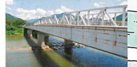
昭和40年の台風で流出し、架け替 えられた糸井橋。円山川沿いにある ことから、水害も多かったという。
