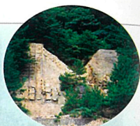
沖浦鉱山跡 大正10年から21年間、金や銀、銅が採掘された沖浦鉱山。最盛期には約300人が働いていた。縦坑は14段階あり、それぞれの階から横坑が放射線状に伸びている。
