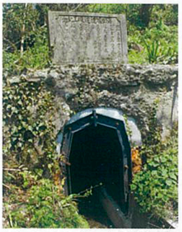
昭和26年に竣工した「浮田環隧道」は延長320メートル、6町歩の田畑の水を潤している。
