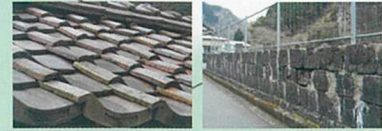
赤褐色の「生野瓦」や、鉱石を製錬する際にできたカスを固めた「カラミ石」の塀壁など、鉱山町らしいまち並みが残る。
