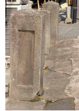
南側の橋の欄干跡。今もこの下には、農業用水、防火用水として使われている新川が流れる。今は暗きよとなっており、新川の上に建物が拡張された。「子どもの頃は建物がなく、川遊びをしていた」と、市場内で鮮魚店を営む村尾清彦さんは教えてくれた。
