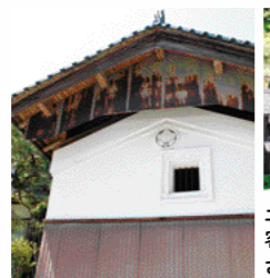
屋根に抜気(ばつき)と呼ばれる越屋根が見える。養蚕を営んでいたのだろう。
