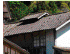
屋根に抜気(ばつき)と呼ばれる越屋根が見える。養蚕を営んでいたのだろう。
